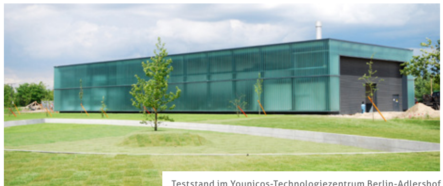
Teststand im Yunicos-Technologiezentrum Berlin-Adlershof
